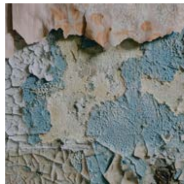
Paredes descascaradas
