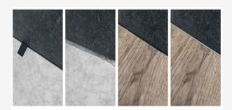
Coloque los azulejos de la pared a una altura de 6mm. Coloque también junta perimetral de 10 mm. entre la pared y C&F. Rellenar el hueco con silicona y colocar la tabla bajo el azulejo. Rejuntar.
