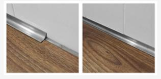
Dejar 10mm. de junta de expansión, rellenar con silicona y cubrir con una moldura escocia.
